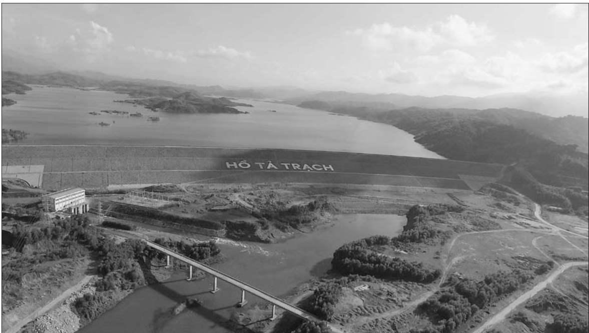
Dự án hồ Tả Trạch, tỉnh Thừa Thiên - Huế
